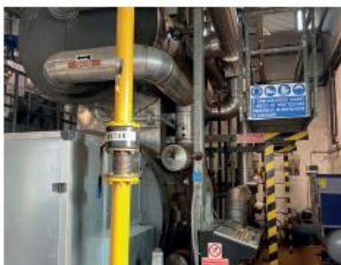
ANTE INTERVENTO Ex Ospedale Campo di Marte Centrale termica ad olio dinamico
