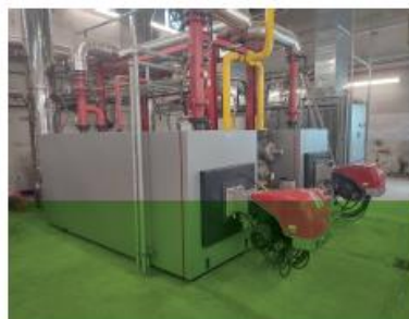
POST INTERVENTO Ex Ospedale Campo di Marte - Centrale termica caldaie a gas a condensazione e cogeneratore
